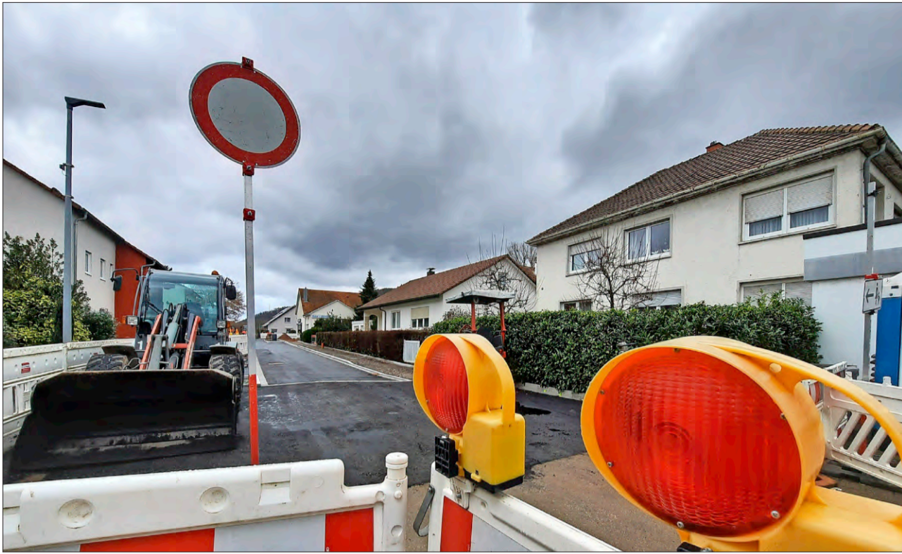
Mit den Arbeiten am zweiten Bauabschnitt sollen kommende Woche beginnen.
