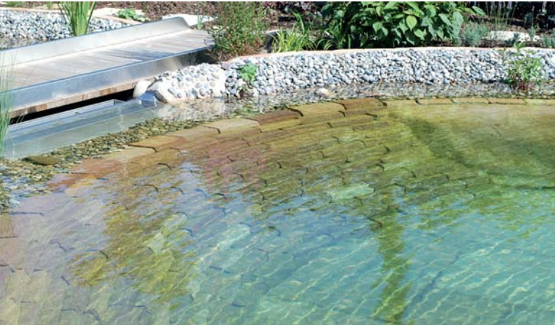
Bei dem Pilot-Schwimmteich kombinierte Martin Bahner das neue Material mit gesetzten Mauern, um Spannungsrisse zu vermeiden.
