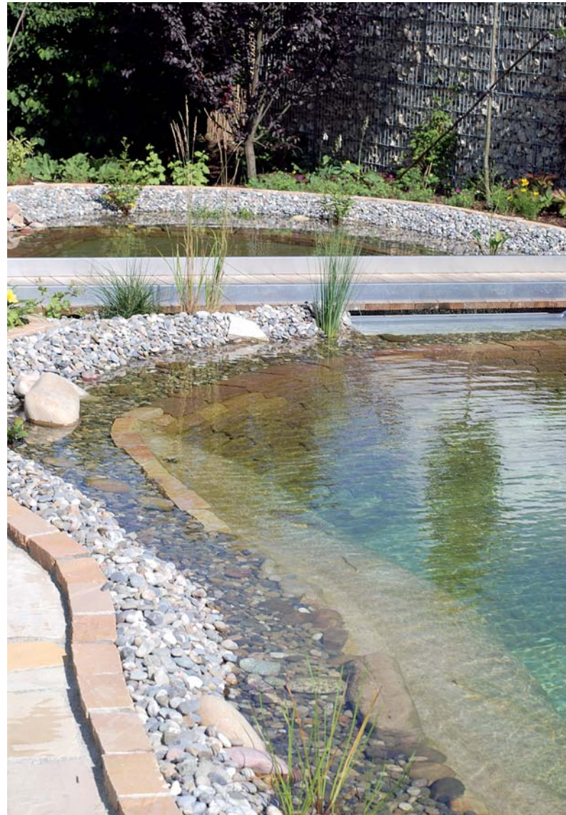
Bei dem Pilot-Schwimmteich kombinierte Martin Bahner das neue Material mit gesetzten Mauern, um Spannungsrisse zu vermeiden.
